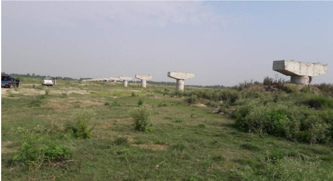
हुलाकी राजमार्ग अन्तर्गत पर्ने निर्माणाधीन बाग्मती पुल, रौतहट ।
